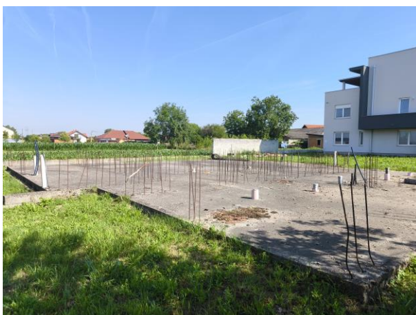
Slika 1 - 4: Djelomično izgrađena zemljišta (višestambena zgrada 24 × 4 stana i temeljna ploča
